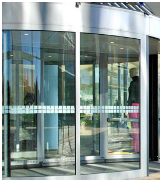
Karuselldörrar i rostfritt stål. Laserskurna, kantbockade, limmade, och monterade.
